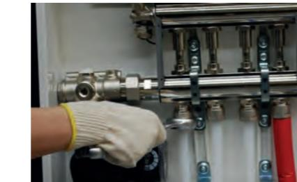
6. Collegamento idraulico da cui effettuare il riempimento dell'impianto.
