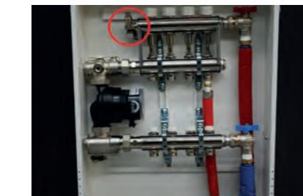
7. Riempimento impianto: chiudere le valvole di andata/ritorno del circuito primario (rossa e blu); apertura manuale del primo otturatore termostatico e ruotando in senso antiorario l'apposita manopola.
