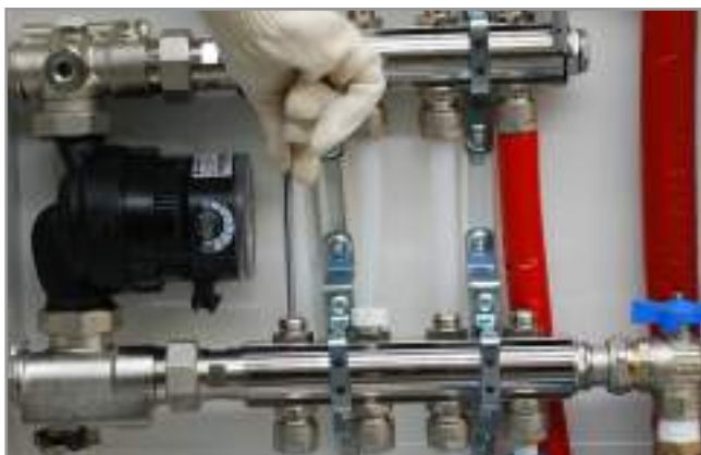
8. Riempimento impianto: apertura del primo detentore ruotando la chiave a brugola in senso antiorario Filling the system: open the first lockshield by turning the Allen wrench anticlockwise
