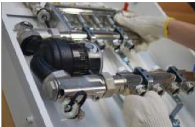
3. Installare la centralina nella apposita cassetta, agganciandola prima sulle staffe in alto e successivamente su quelle in basso Install the control unit in the specific case, first releasing it from the top brackets and then from the bottom ones
