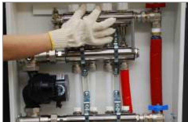
7. Riempimento impianto: chiusura degli otturatori successivi ruotando in senso orario le apposite manopole Filling the system: close the following shutters by turning the specific knobs clockwise
