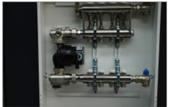
3. Installare la centralina nella apposita cassetta, agganciandola prima sulle staffe in alto e successivamente su quelle in basso Install the control unit in the specific case, first releasing it from the top brackets and then from the bottom ones
