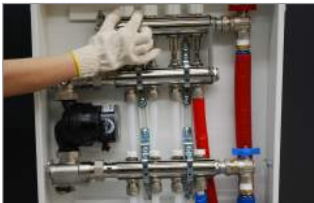
6. Riempimento impianto: chiudere le valvole di andata/ritorno del circuito primario (rossa e blu); apertura manuale del primo otturatore termostatico e ruotando in senso antiorario l'apposita manopola Filling the system: close the entry/return valves of the primary circuit (red and blue); open manually the first thermostatic shutter and turn the specific knob anticlockwise
