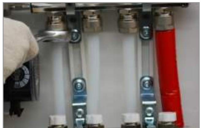
5. Collegamento e serraggio del secondario andata/ritorno dal sistema in bassa temperatura e alta temperatura Connection and tightening of entry/return flow secondary circuit from high temperature and low temperature system
