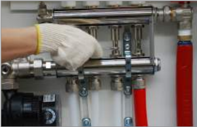
12. Regolazione della temperatura del liquido dei circuiti secondari con chiave inglese 11 mm. Liquid temperature adjustment of secondary circuits with 11 mm spanner.
